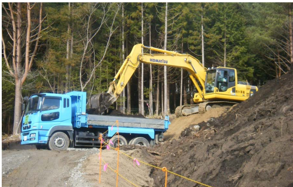
▲現場発生土をダンプトラックに積み込み
