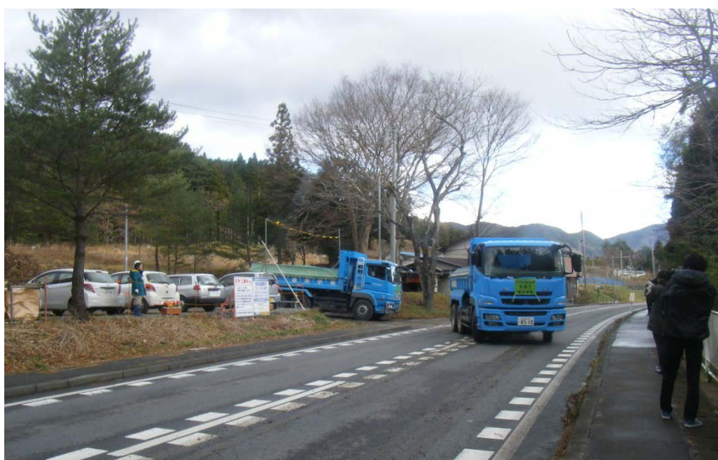
▲現場発生土運搬
