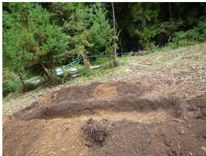
▲ 10/2 箇所A 試掘完了
