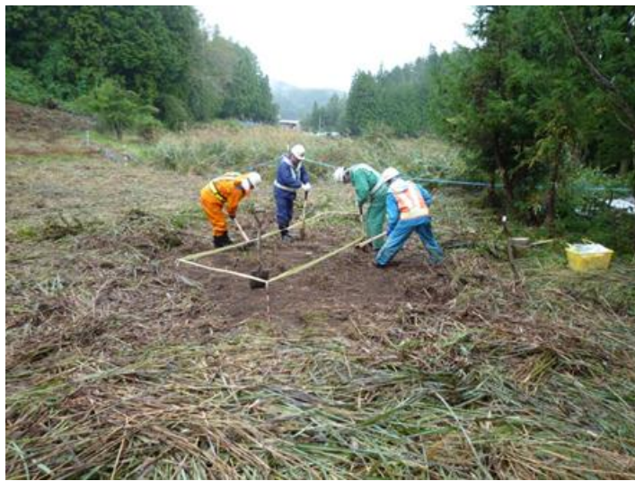
▲ 10/2 箇所A 試掘状況
