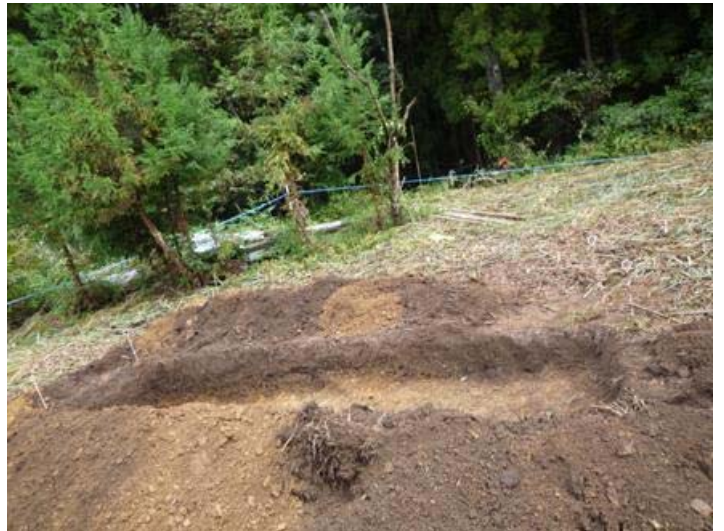
▲ 10/2 箇所A 試掘完了
