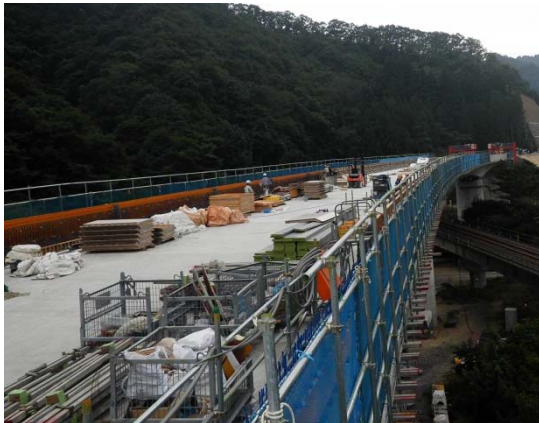
▲工事中の羅賀高架橋全景
