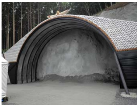
▲二郷山トンネル宮守IC側坑口
