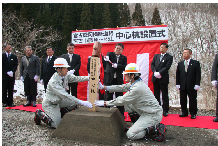
宮古市長の中心杭打設
