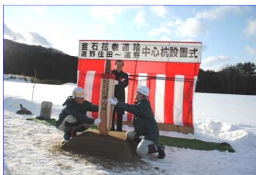
▲遠野市長による中心杭打設
