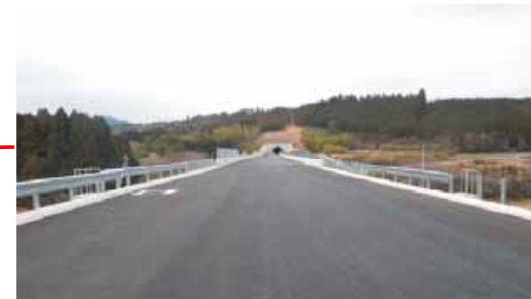
舗装(基層)・ガードレール設置完了 (避難指示解除準備区域)
