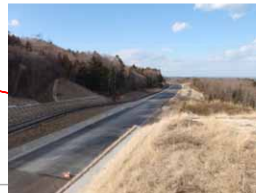
舗装工事着手
