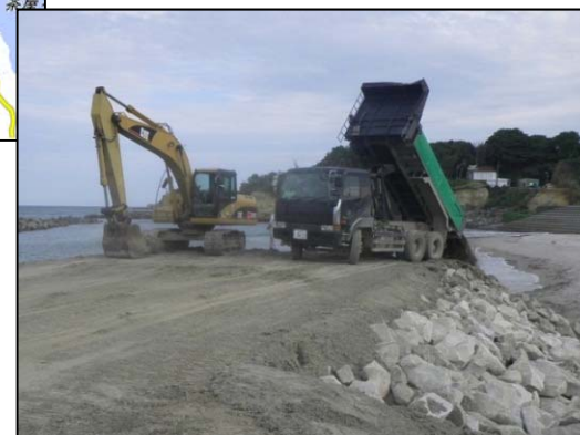
【ストックヤードへの搬入状況(大洲海岸)】
