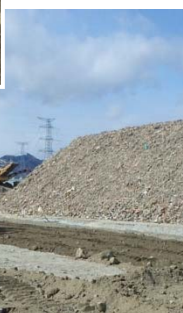
【処理施設の造成状況】
