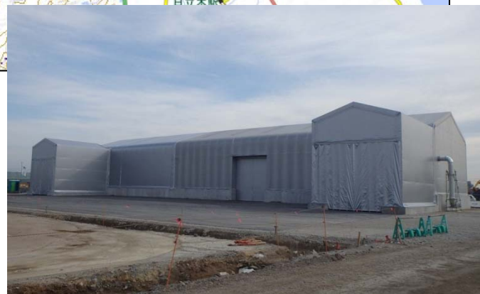
【完成した除染廃棄物破碎処理施設】
