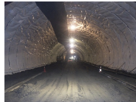
防水シート貼付
