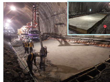
インバートコンクリート打設
