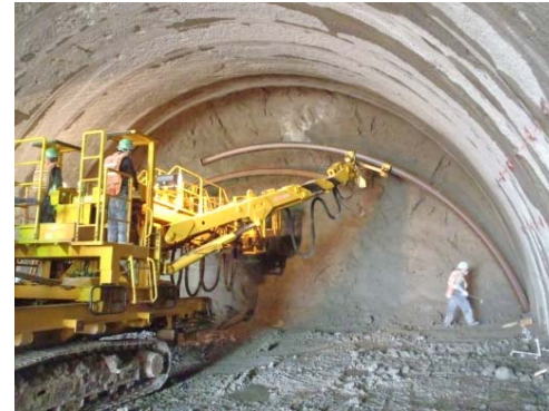
支保工建込み
