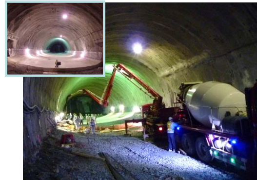
インバートコンクリート打設
