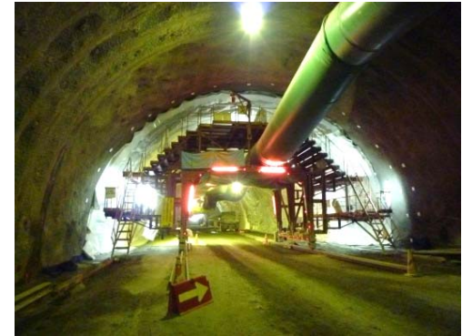
防水シート貼付
