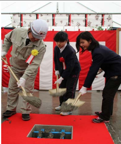
▲最終コンクリート投入
