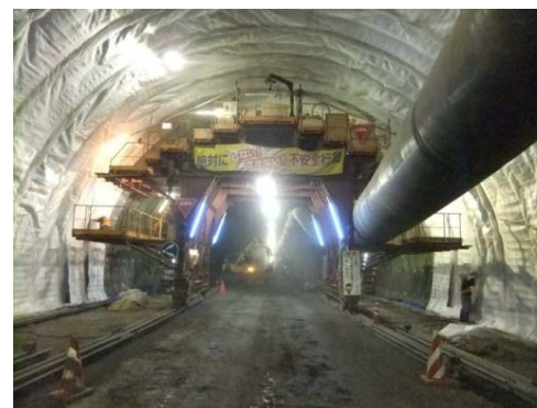
防水シート貼付
