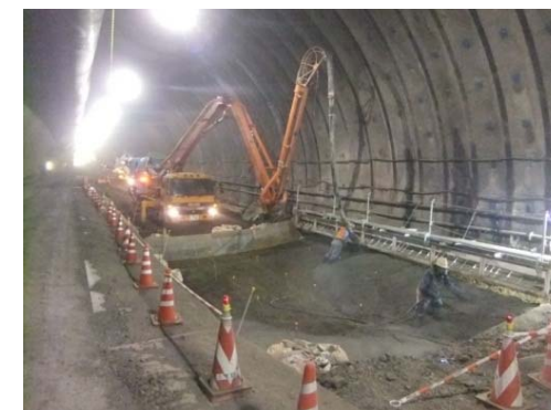
コンクリート打設
