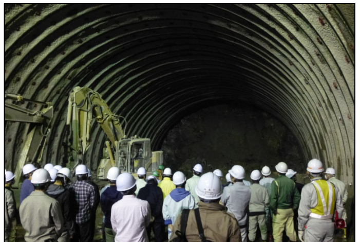
【発破後の切羽見学(庄司淵トンネル)】
