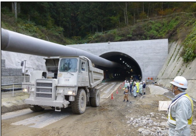
【運搬機械の見学(庄司淵トンネル)】
