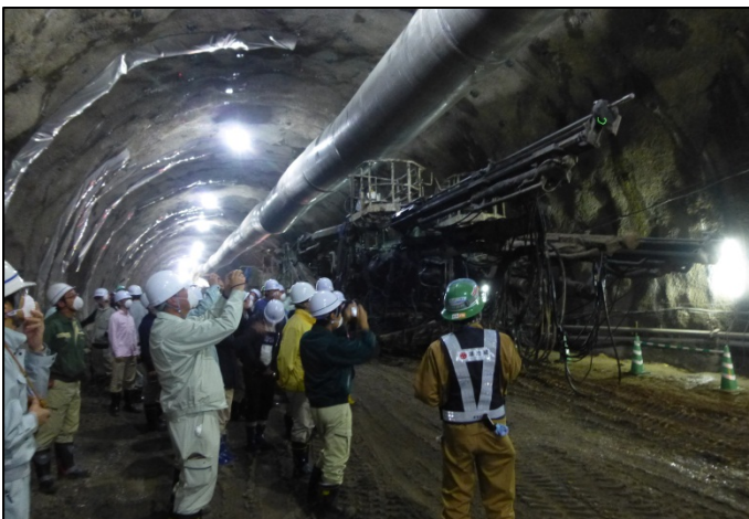
【掘削機械の見学(庄司淵トンネル)】
