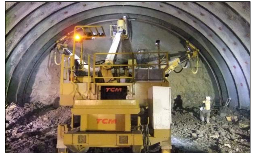
トンネル施工状況写真
