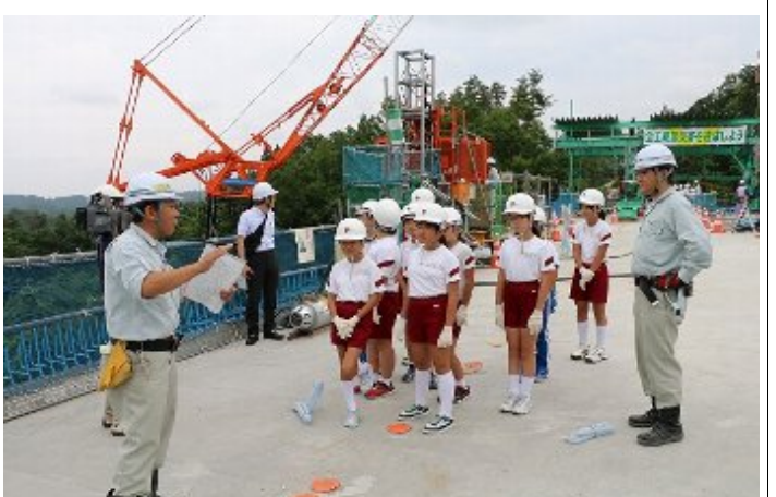
橋面での施工方法説明状況
