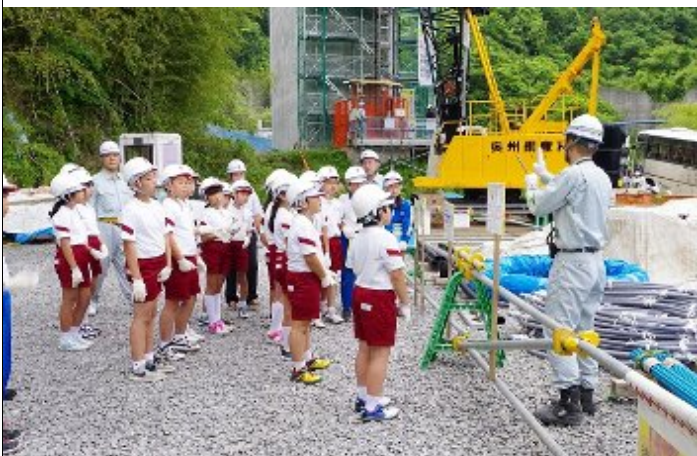
施工で使用している材料の説明状況
