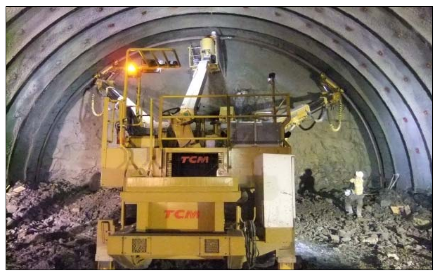
トンネル施工状況写真
