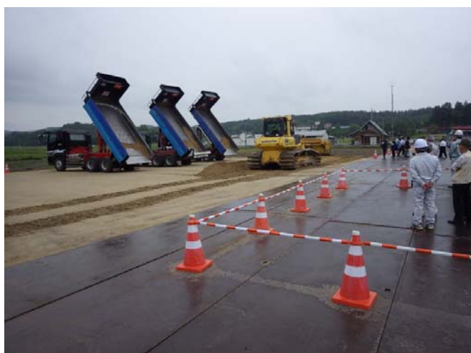
発生土砂敷均し状況
