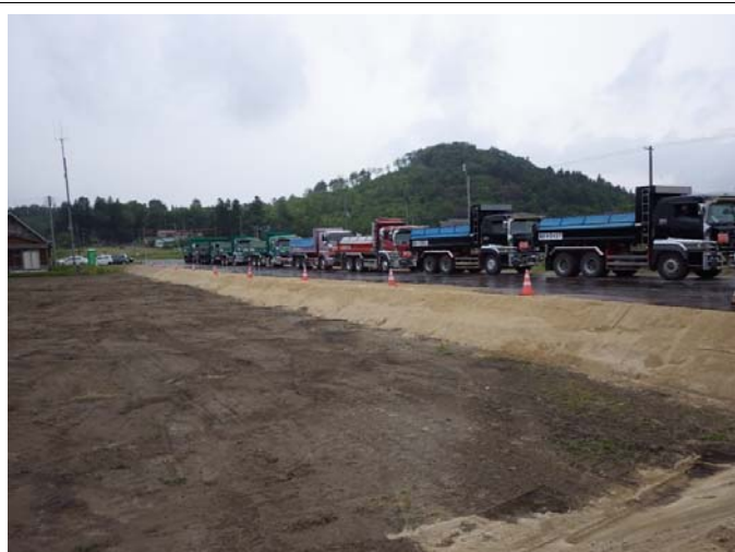
発生土砂運搬状況
