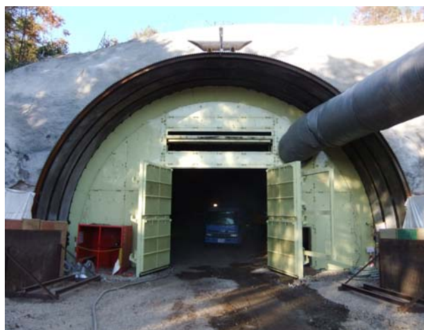
<平成26年11月末 坑口から約80m掘削予定>
