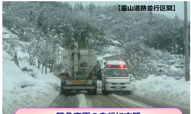
緊急車両の走行に支障
