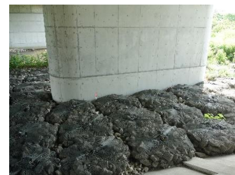
根固め工(近景)
