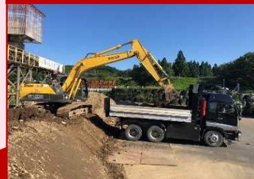
ベルトコンベアで運ばれた土砂を、ここからダンプトラックに積んで搬出します
