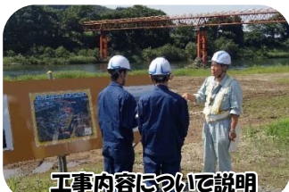
工事内容について説明
