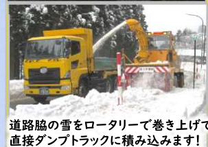
国道7号の排雪作業は、機械の 連携走行で行います！
