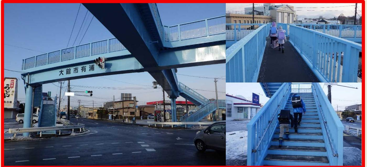
有浦横断歩道橋は老朽化が著しいことから、今年6月18日から通行止めをして塗装の塗り替えと融雪施設補修工事を行っていましたが、**12月25日(金) 午前7時に開通しました。**
