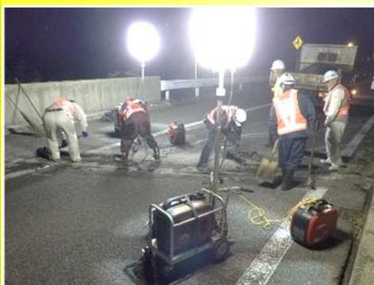
秋田自動車道は自動車専用道路であり、安全に作業することができるよう、交通量の少ない夜間に区間を限定し、全面通行止めにより舗装の補修などを行います。翌朝には車が通行できるよう、夜間の作業は時間との戦いです。
