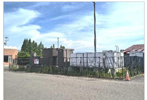
情報プラザの隣に整備された連続72時間稼働できる非常用発電設備・2万リットルをためられる貯水槽
