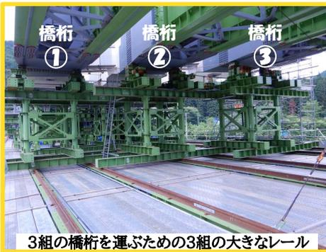
3組の橋桁を運ぶための3組の大きなレール
