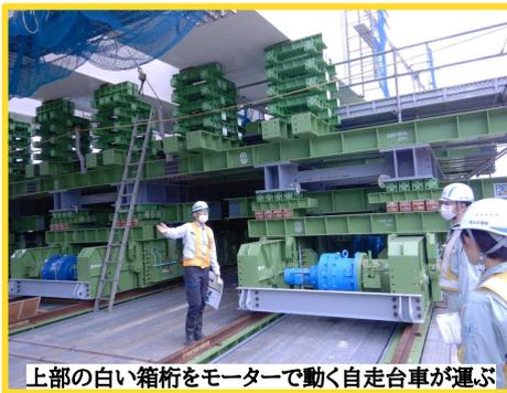
上部の白い箱桁をモーターで動く自走台車が運ぶ
