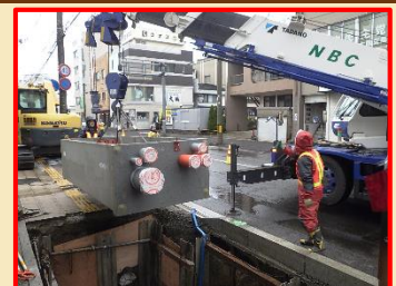
電線共同溝特殊柵・管路設置の様子
