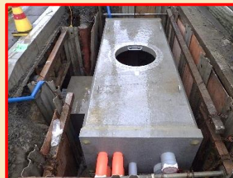
電線共同溝特殊柵・管路設置の様子
