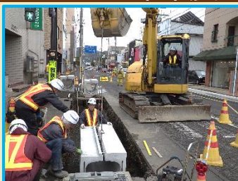
円形側溝設置の様子
