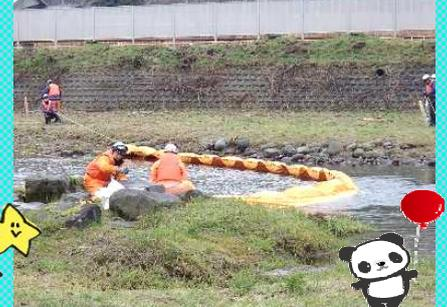
オイルフェンスは1本10m、設置する際には川幅にあわせて設置するため、1本1本をファスナーと固定金具で連結して設置します。今回は2本20mで川に設置。訓練参加者によりファスナー連結作業を実演し連結完了後、フェンスを川まで運び、固定用の杭にフェンス端部を固定して設置後、流出物を吸収する吸着マットを入れ完了。その後、小排水路、支川等からの流出防素対策も実演され、無事訓練終了です。
