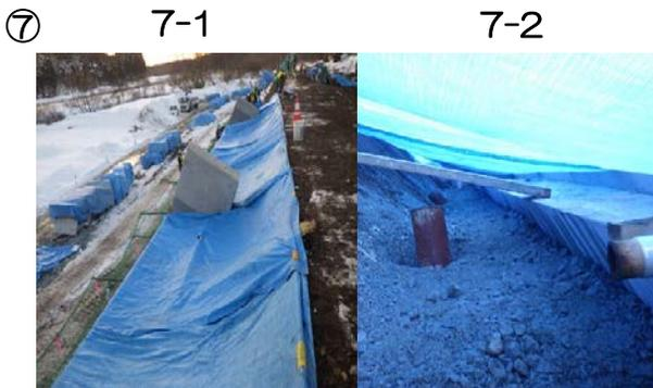
⑦冬期間は、外気温が氷点下になるためコンクリート全体をシートで囲います。内部の温度を5℃以上保つために煉炭コンロを入れて保温養生します。
