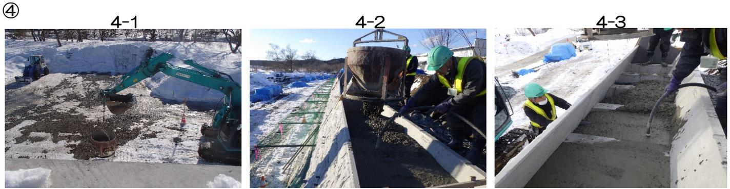
④大型ブロックの中にコンクリートを入れ、バイブレータという機械の振動で締め固めを行います。振動を与えることによって隅々までコンクリートが行き届き、また内部の気泡を追い出して耐久性に優れたコンクリートを作ることができます。
