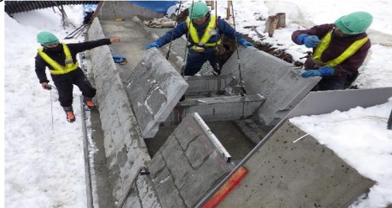
②クレーン仕様バックホウで大型ブロックを据え付けます。
