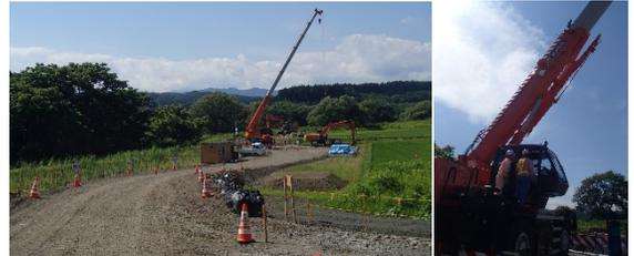
掘った土を運搬するための工事用の道路を作っていました。排水路を横断するための門型カルバートの基礎工事を行っていました。
