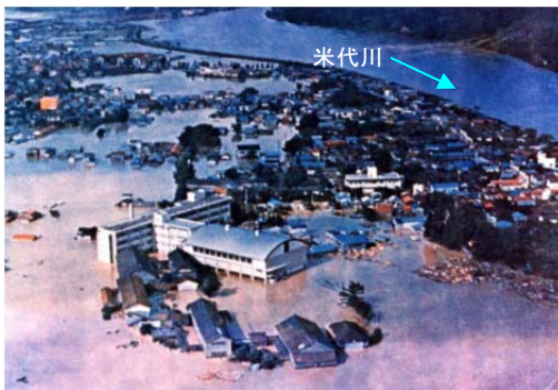
能代市二ツ井町付近の浸水状況
