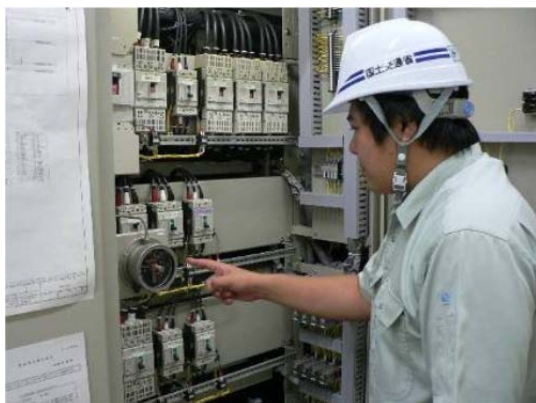
電気設備の点検状況
