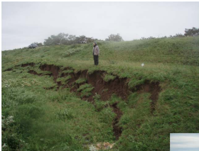
平成 19 年 9 月撮影 法崩被害の状況（能代市 鶴形地区）
