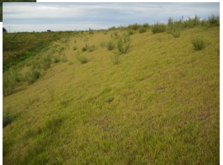
平成 24 年 9 月撮影 堤防質的整備の状況 （能代市 鶴形地区）
