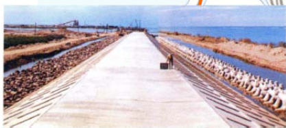
中島導流堤 (S47 完成)
