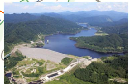
森吉山ダム (H23 完成)
