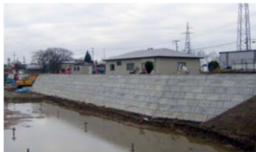
常盤地区築堤 (H23 完成) 森県
