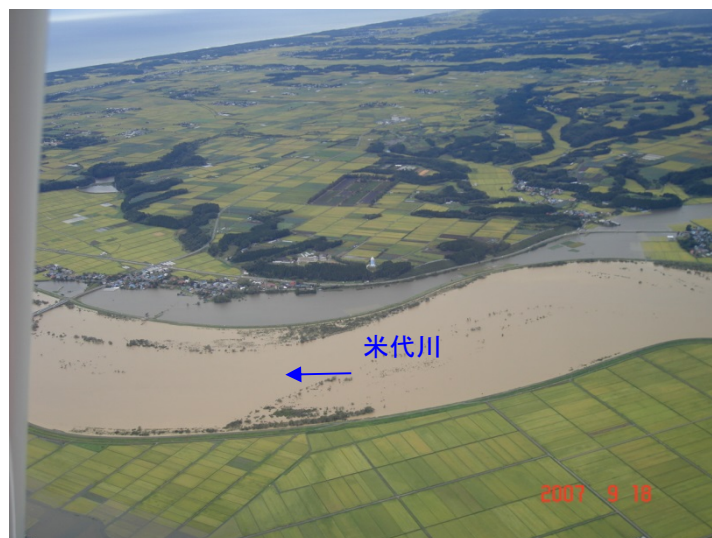
平成 19 年 9 月洪水状況（能代市朴瀬地区）
