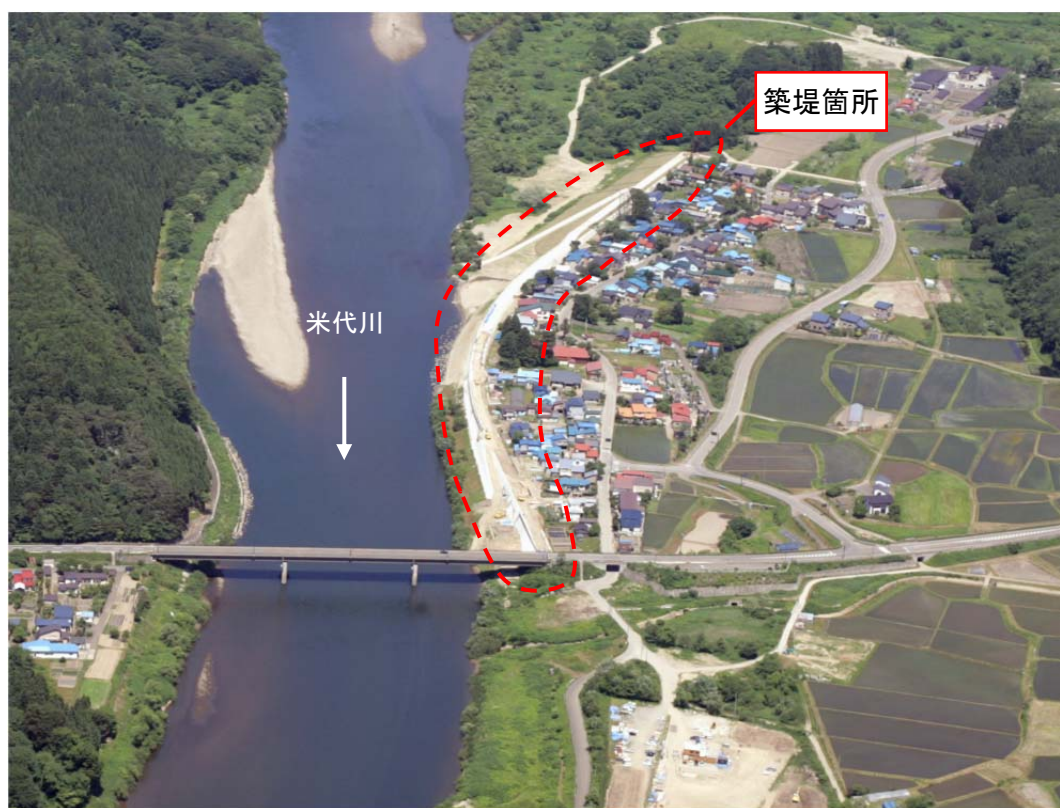
能代市二ツ井町麻生築堤状況（平成 23 年 6 月撮影）
