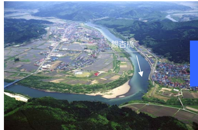
ふたついで 二ツ井右岸地区 整備前の状況（H19）
