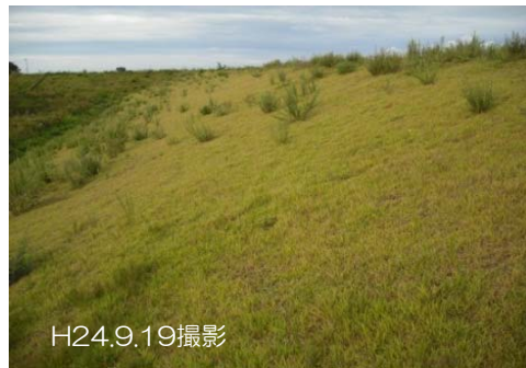
H24.9.19撮影 鶴形地区 整備後の状況（H19完）
