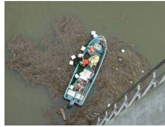
貯水池内の流木及び塵芥撤去
