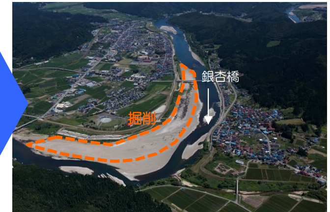
二ツ井右岸地区 整備後の状況（H26）
