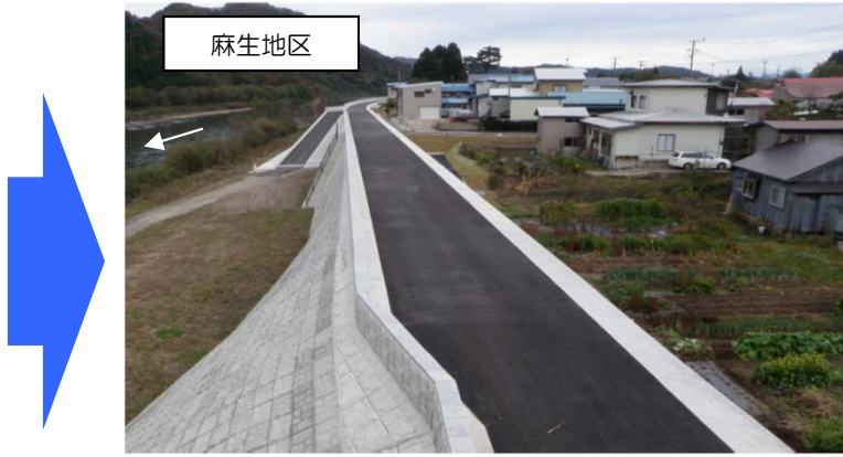
整備後の状況
