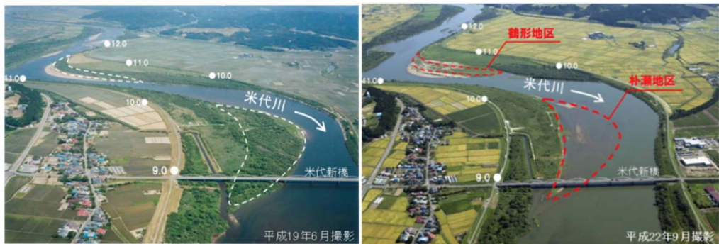
河道掘削前（平成19年6月撮影）
