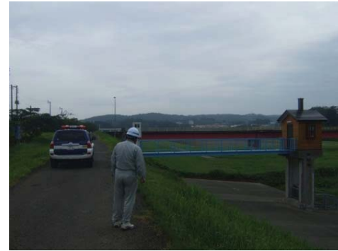
河川巡視による不法投棄・不法占用の監視
