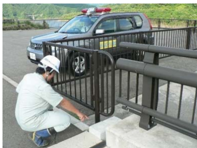
管理施設の点検状況
