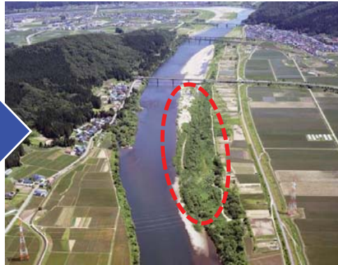
切石地区樹木繁茂の状況（H24）
