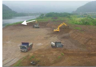
河道掘削状況（能代市切石地区）
