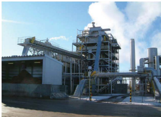
バイオマス発電施設
