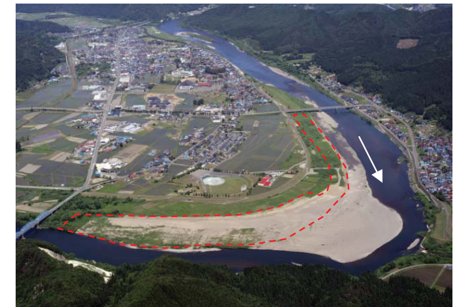
二ツ井右岸地区 整備後の状況
