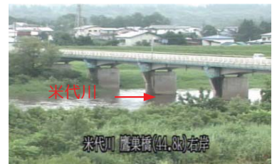
鷹巣水位観測所の状況
