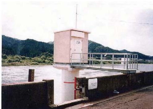
二ツ井水位観測所
