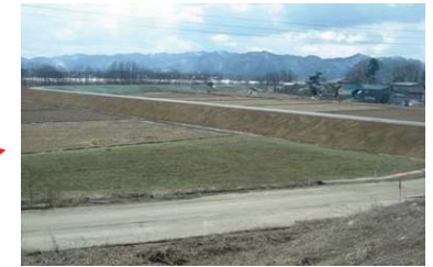
築堤利用（大館市山田渡地区） やまだわたり
