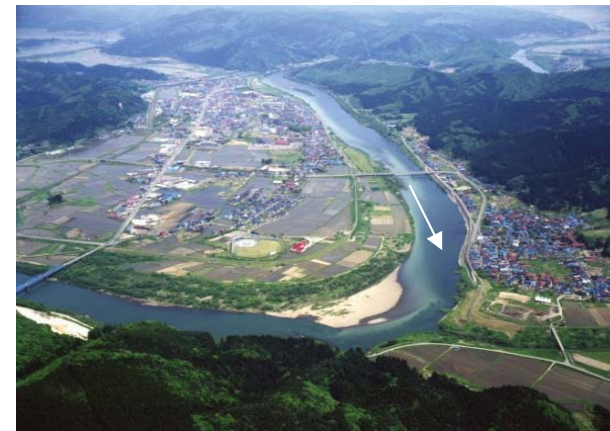
ふたついで 二ツ井右岸地区 整備前の状況
