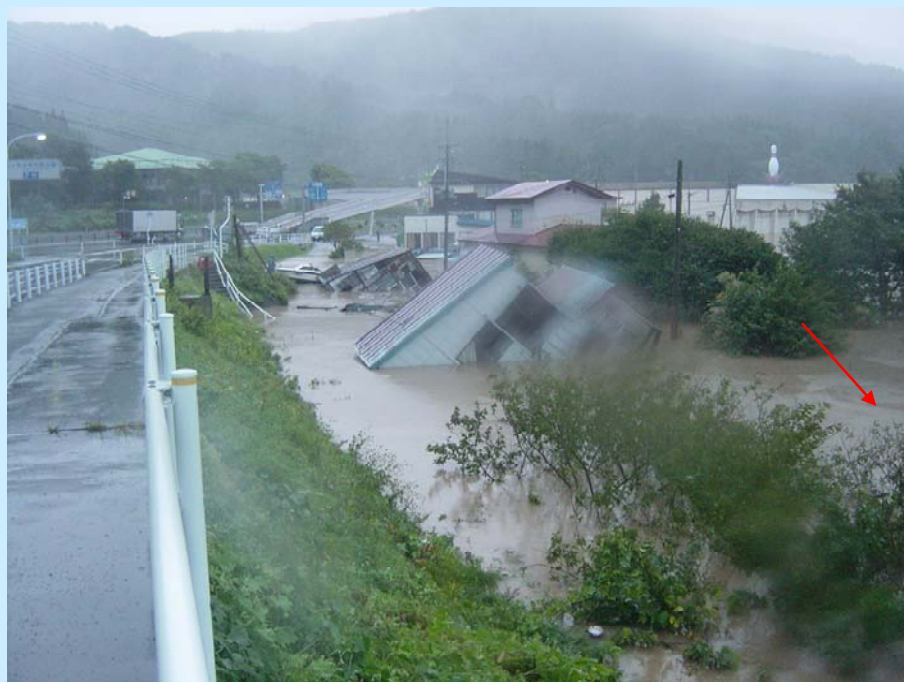
H19.9出水における家屋等被害状況
