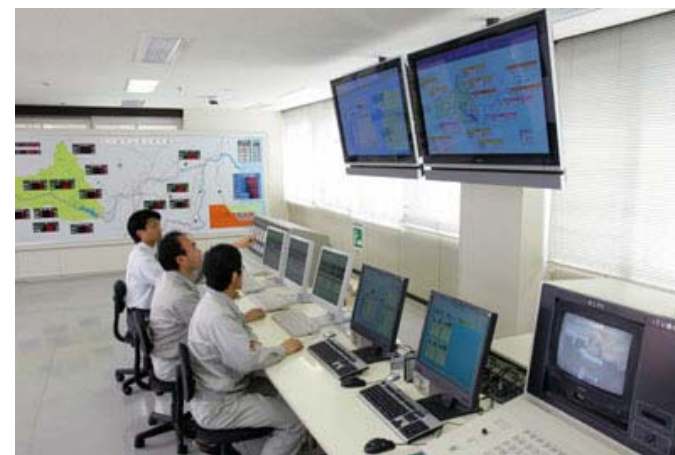
ダム操作状況(七ヶ宿ダムの例)
