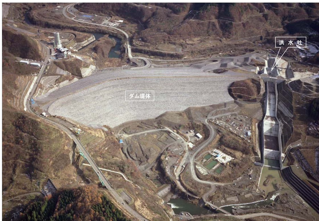
建設中の森吉山ダム
