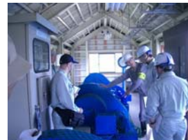
施設点検の様子
