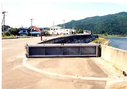
河川管理施設 陸閘 (仁鮎第 3 陸閘)
