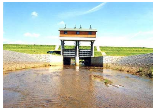
河川管理施設 水門 (前山川水門)
