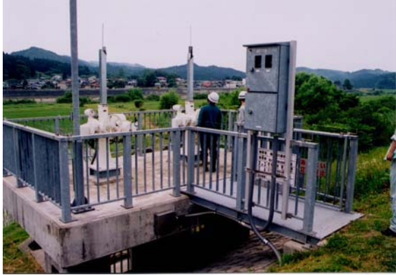
河川管理施設の点検
