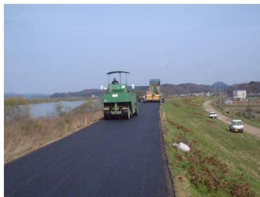
堤防天端舗装状況
