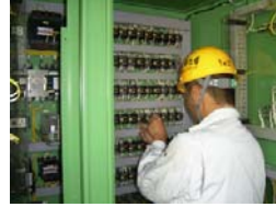
機側操作盤の点検状況
