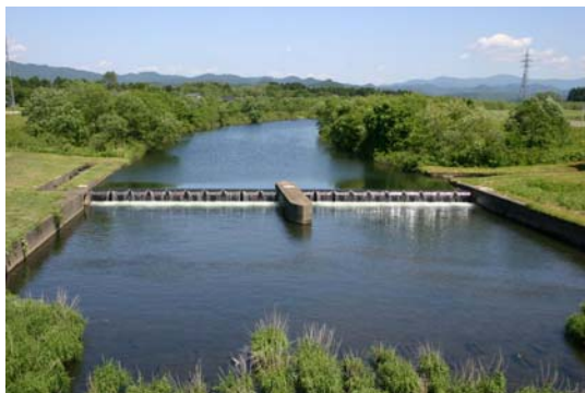
河川管理施設 堰 (小猿部川可動堰)
