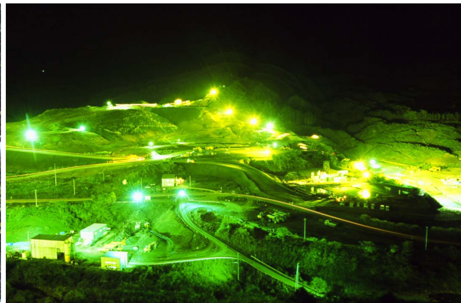
夜間作業の照明の状況
