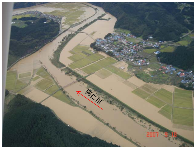
浸水状況(北秋田市木戸石付近)
