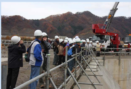
機械設備関係の工事状況を視察した
