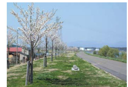
④ 中川原桜つつみ (米代川左岸4.6k付近)
