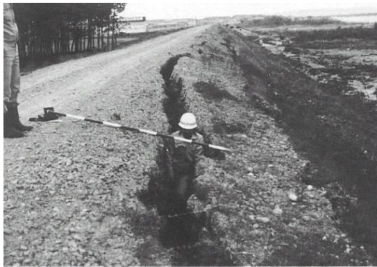
日本海中部地震での被災状況の把握
