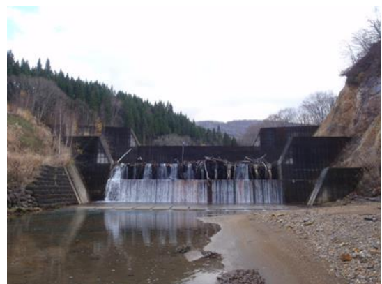
熊沢川砂防堰堤 (平成 12 年完成 事業主体：秋田県)
