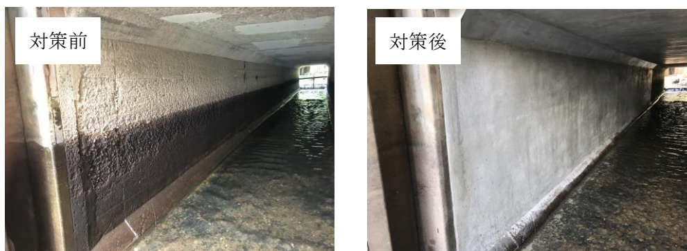
樋管の老朽化対策（漏水補修・断面修復）の状況（羽立排水樋管）
