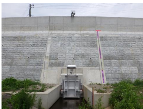
河川管理施設 樋門・樋管 (川口排水樋門)
