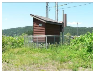
森吉山ダム 警報施設
