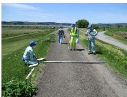
堤防点検の様子
