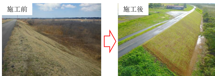
堤防法面の補修状況
