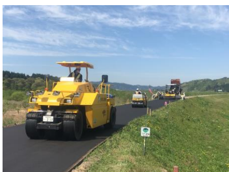
堤防天端の舗装状況
