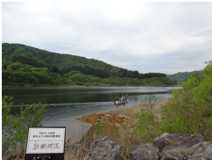
ダム堆砂測量の様子
