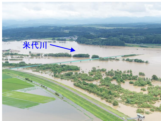
令和 4 年 8 月洪水による被災状況 (北秋田市 坊沢地区)
