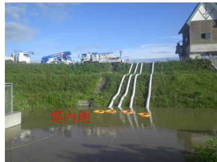
排水ポンプ車稼働状況
