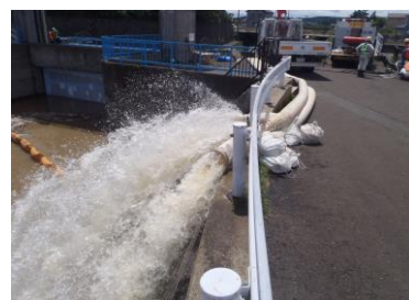
排水ポンプ車の出動状況
