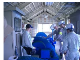
施設点検の様子
