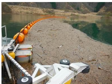
森吉山ダム 流木止施設
