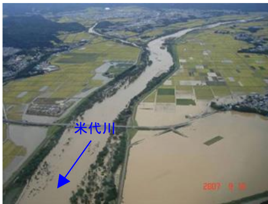
平成 19 年 9 月洪水による被災状況 (大館市 川口板沢地区)
