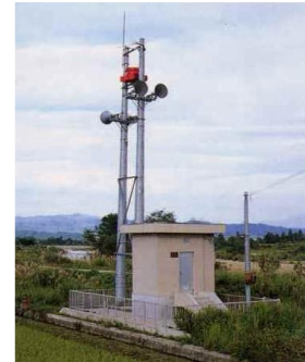
警報装置の状況
