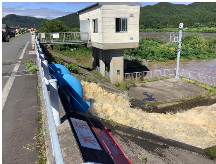
救急内水ポンプによる排除状況（能代市ニツ井町比井野地区）
