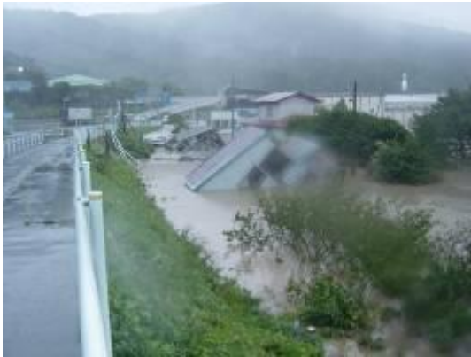
平成 19 年 9 月洪水による被災状況 (能代市二ツ井町 道の駅ふたついで付近)
