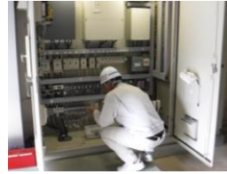
機側操作盤の点検状況
