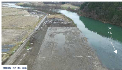
長坂地区河道掘削は、5万6千m 3 の土砂掘削を実施
