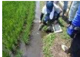
調整板設置（能代市東雲原地区）
