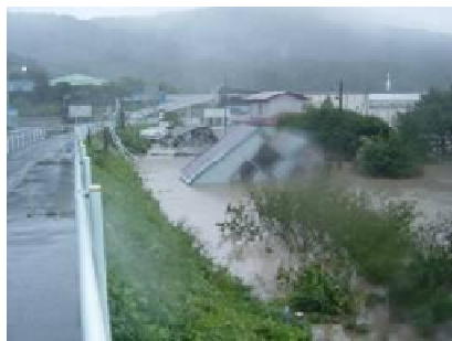
平成19年9月洪水による被災状況 (能代市二ツ井町 ヘルスセンター付近)
