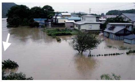
能代市麻生地区の浸水状況
