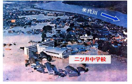
能代市ニツ井町の浸水状況
