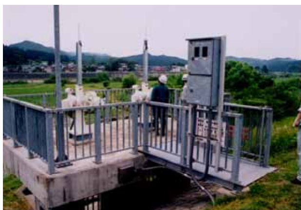
河川管理施設の点検
