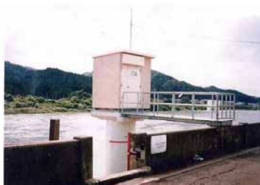
二ツ井水位観測所
