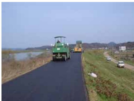
堤防天端舗装状況
