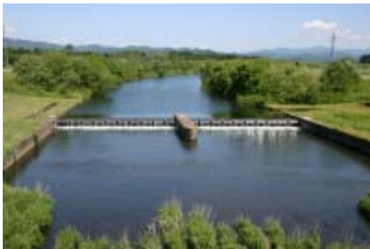
河川管理施設 堰（小猿部川可動堰）
