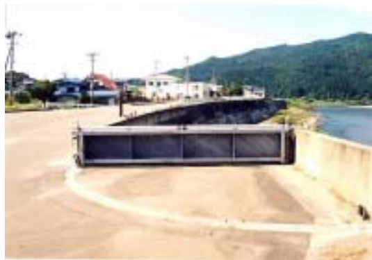
河川管理施設 陸閘（仁鮎第3陸閘）
