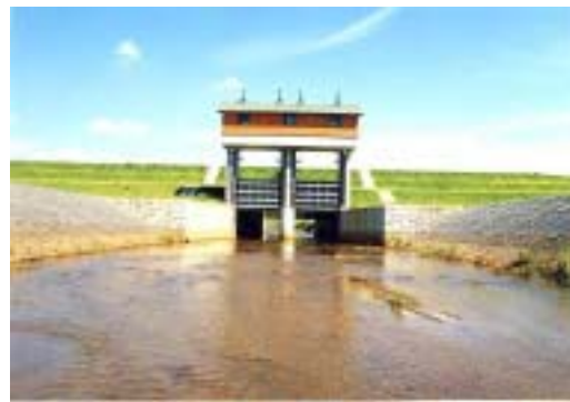
河川管理施設 水門（前山川水門）
