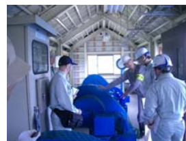
施設点検の様子
