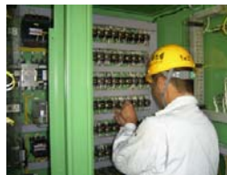
機側操作盤の点検状況
