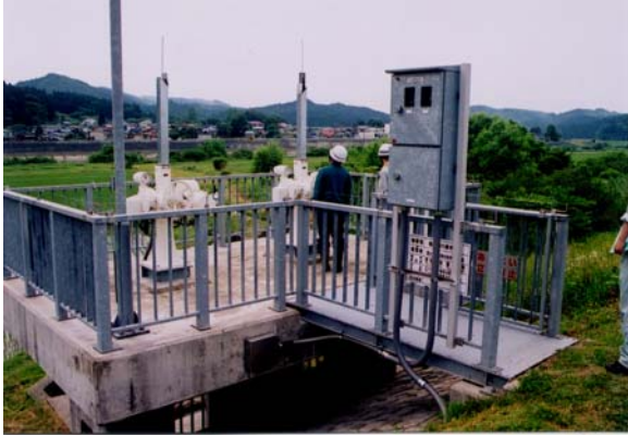
河川管理施設の点検
