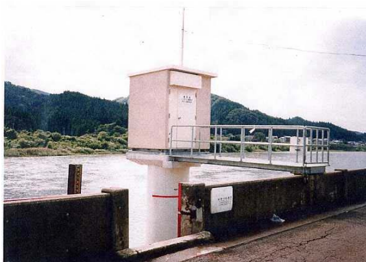
二ツ井水位観測所
