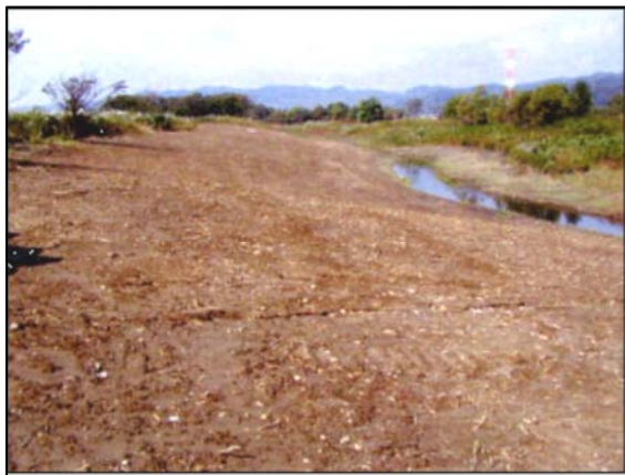
再生地造成直後（平成 13 年 10 月）
