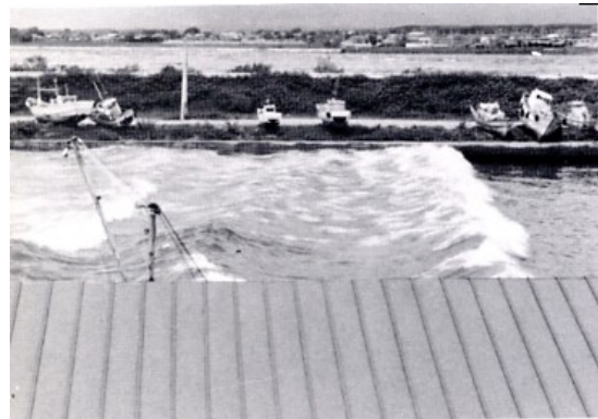
日本海中部地震での津波状況
