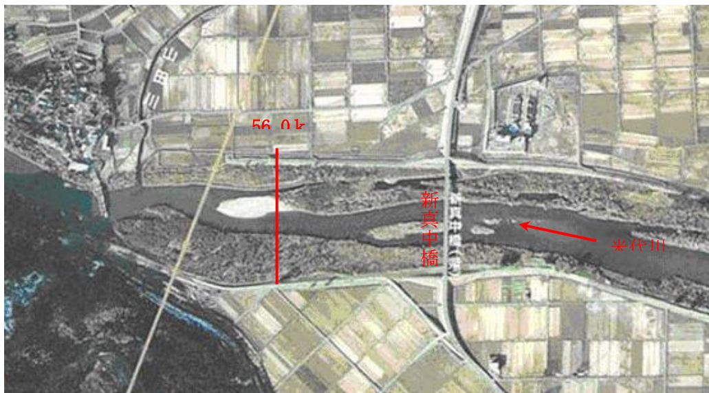
平成 10 年撮影 河道内の植生状況 [中州や川寄りに樹木が繁茂し流下能力を減少させています。]
