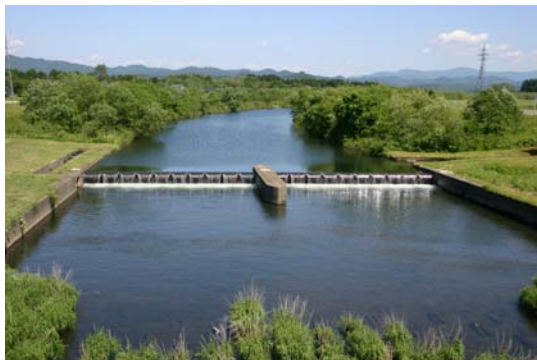
河川管理施設 堰 (小猿部川可動堰)
