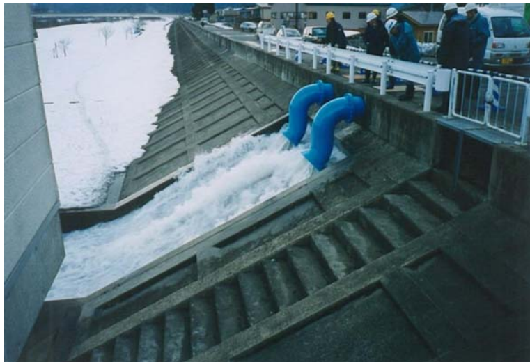
救急内水ポンプによる排除状況（能代市二ツ井町薄井地区）
