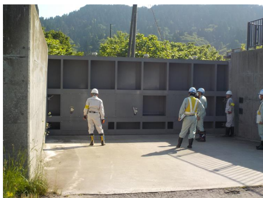
河川管理施設の点検（陸閘）
