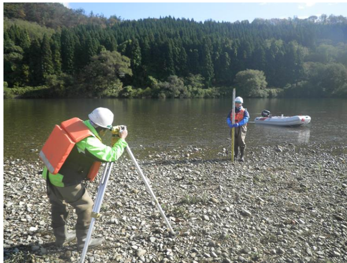
河川横断測量の様子
