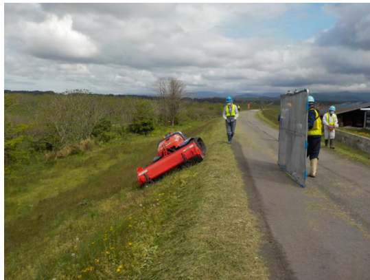
堤防除草の状況
