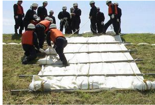
シート張り工 訓練状況
