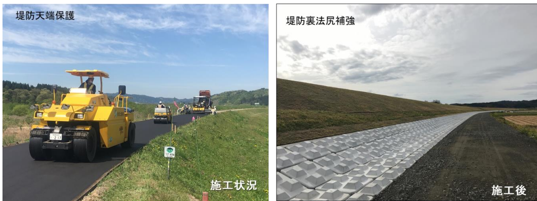
危機管理型ハード対策の施工状況
