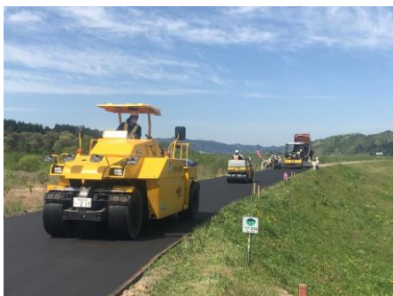
堤防天端の舗装状況
