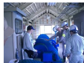
施設点検の様子
