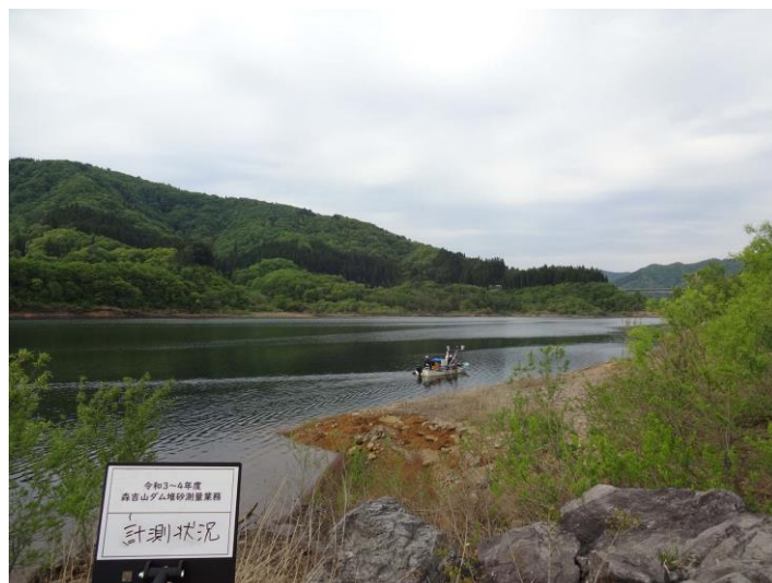
ダム堆砂測量の様子
