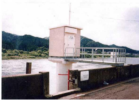
二ツ井水位観測所
