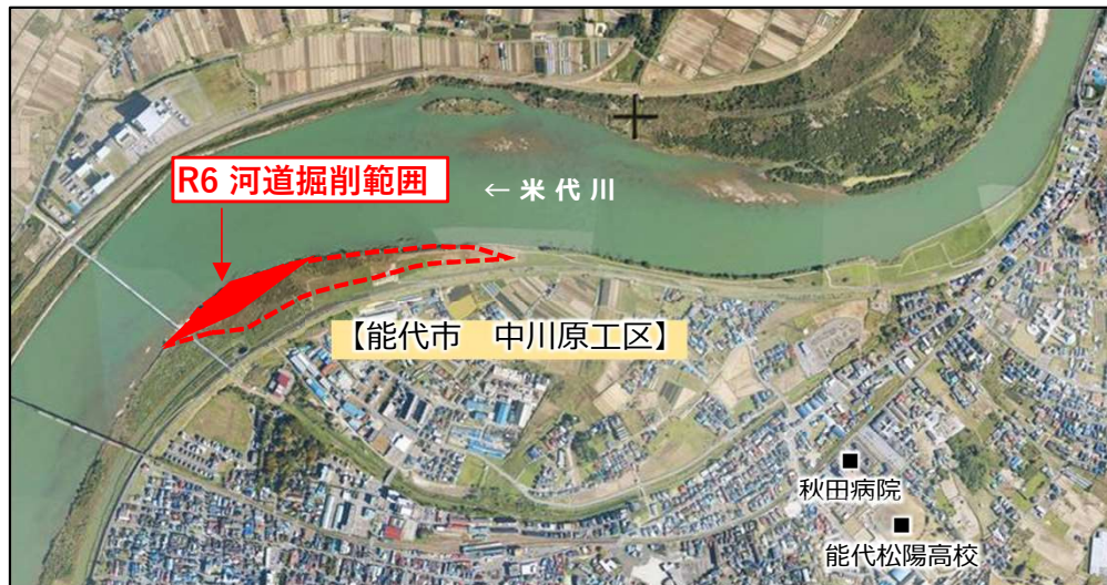
米代川能代地区河道掘削事業 中川原工区
