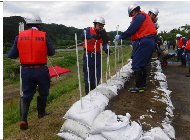
積み土のう工法
