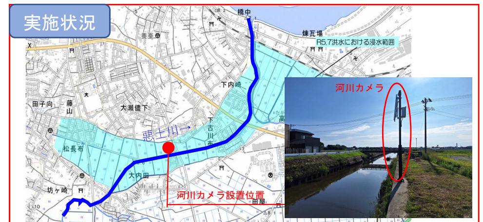
河川カメラ設置位置
