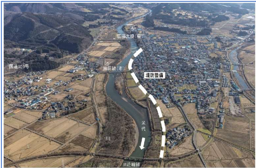
米代川扇田地区堤防整備事業 整備箇所
