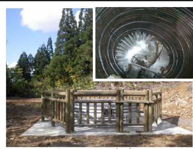
地すべり防止工
