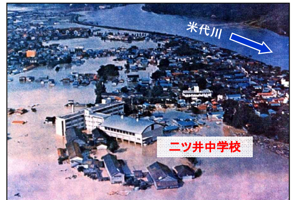
昭和47年7月洪水による被災状況 (旧二ツ井町中心部)
