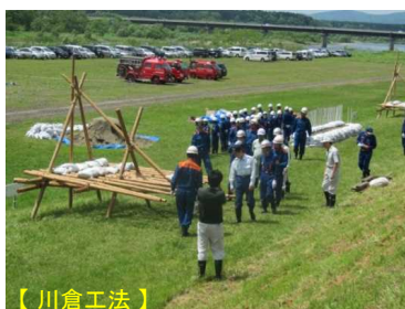
【川倉工法】 水防訓練の実施状況（北秋田市）
