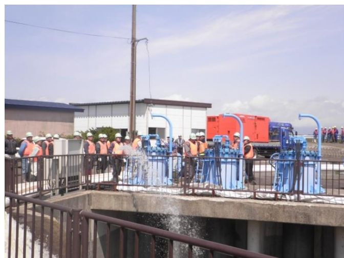
悪土川救急排水機場訓練の様子(R2)
