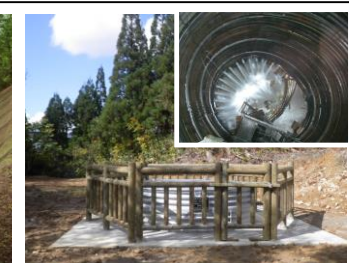
地すべり防止工
