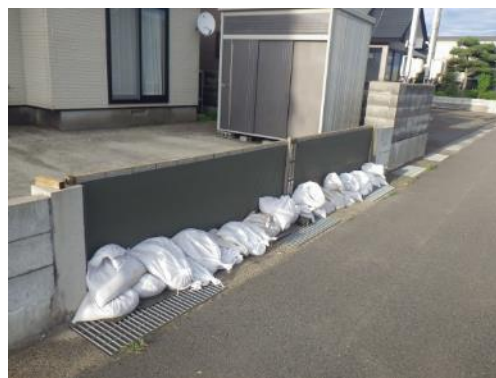
土のうやシートで浸水防止対策を実施した例
