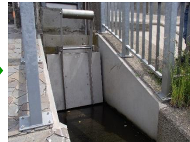
▲落合第4排水樋管
