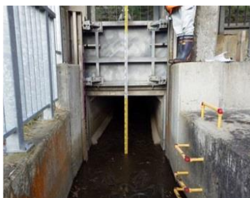
▲現況(ローラーゲート)
