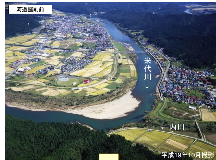
河道掘削状況【能代市ニツ井地区】
