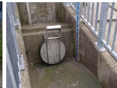
▲中川原排水樋管
