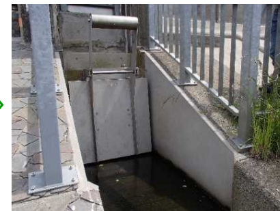
▲落水第4排水樋管
