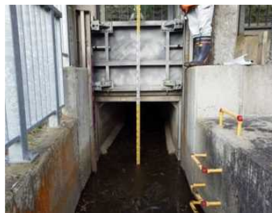
▲現況(ローラーゲート)
