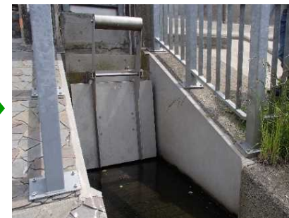
▲落合第4排水樋管
