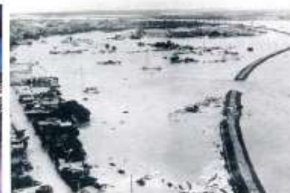
能代市中川原地区の堤防決壊
